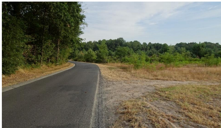
Photographie de l'état initial
